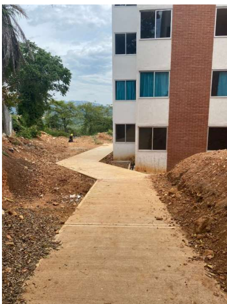
Fotografía 1. Andén de acceso a la torre 7
